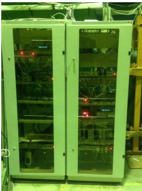
Рис. 104. Стойки систем управления и контроля холодного замедлителя.
