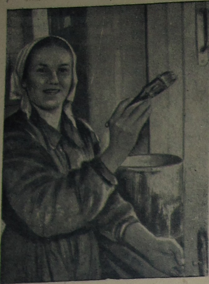
На снимке: бригадир маляров 5-го строительного участка Роза Михайловна Ларионова. Ее бригада перевыполняет нормы выработки, качество выполненных работ хорошее.
