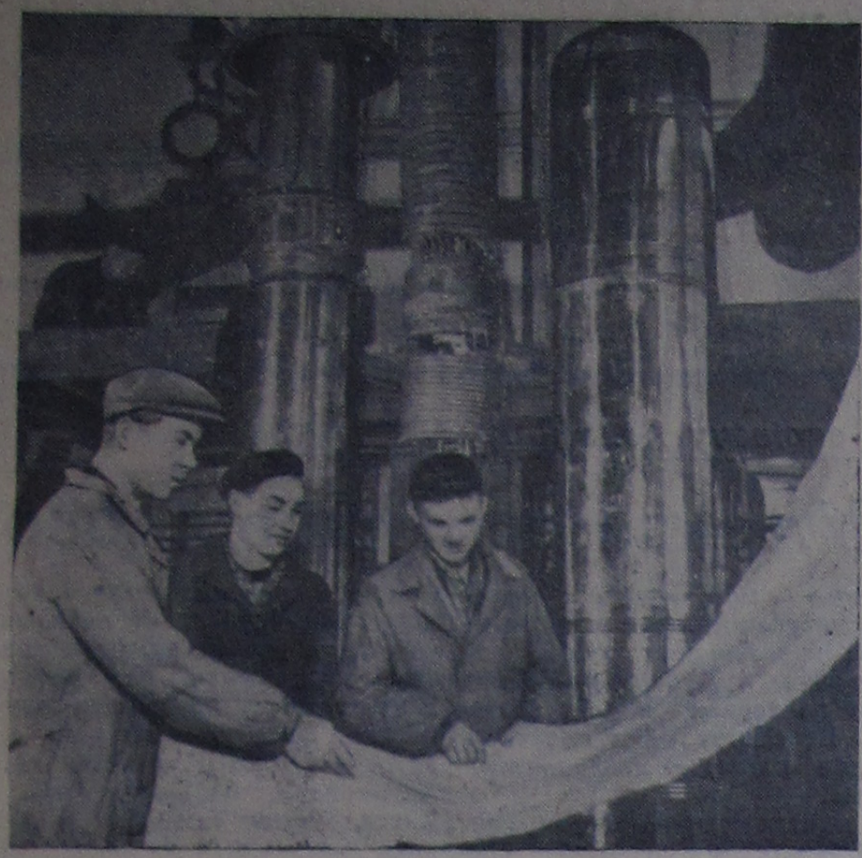
На снимке: Лаборатория высоких энергий. Группа механиков криогенного отдела, успешно ведущая монтаж сложного оборудования криогенного корпуса. Слева направо: А. Демин, В. Сосульников и Э. Комогоров за сборкой гелиевого ожигателя.
