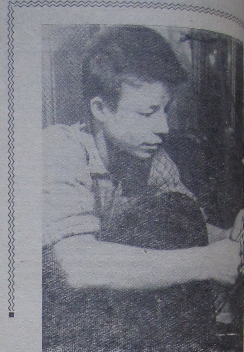
Многие узнал десантник Слава Анполонов за 10 летней практикой на Кировской ГЭС. Вместе с лективом энергетиков участвовал он в больших работах по перемонтажу автоматического управления агрегатов генератора.
