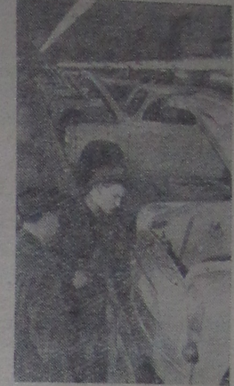
Прокладываются дороги к будущим сооружениям, возводятся жилые дома. Начата проходка обводного тоннеля. Коллектив строителей Ингурской ГЭС, соревнуясь со строителями Братской гидроэлектростанции, поставил перед собой задачу — завершить сооружение гидроэлектростанции в рекордно-короткий срок. На снимке: геодезист К. Сундукян в районе будущей плотины. Фото В. Столярова. Фотохроника ТАСС
