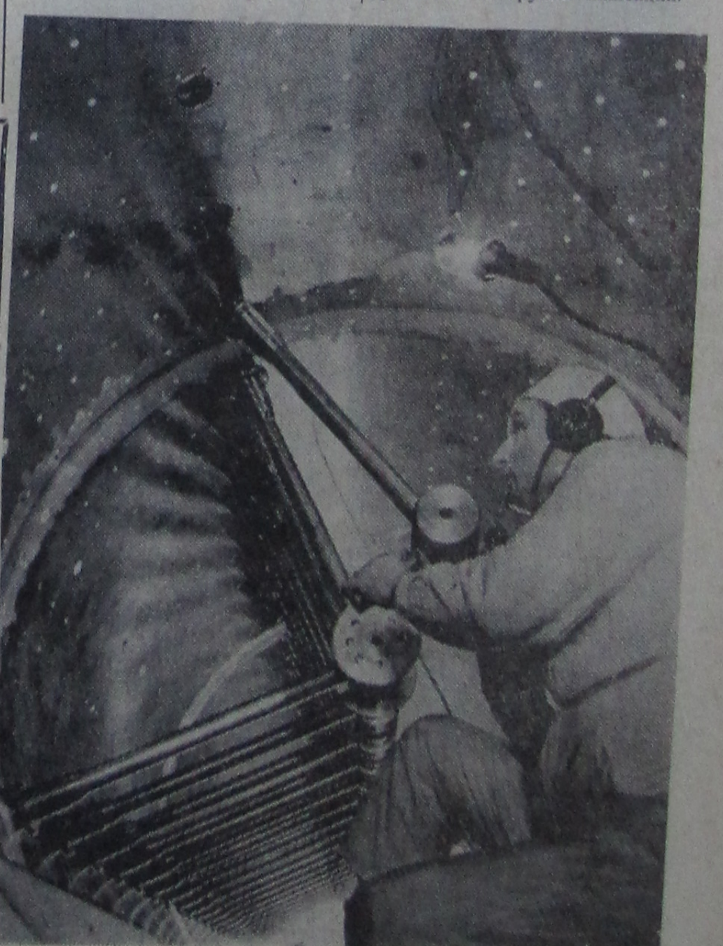
На снимке: старший механик группы инжекции П. Г. Соробайн устанавливает трубки дрейфа в резонаторе ЛУ-20. Фото Ю. Туманова.
