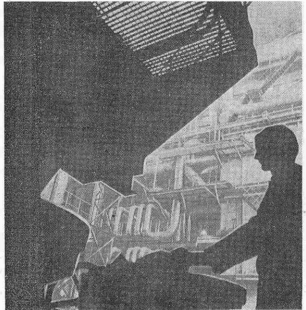
Котел одного турбогенератора — гигантское сооружение высотой в десятиэтажный дом. Управление ведут автоматы, наблюдение — человек.
