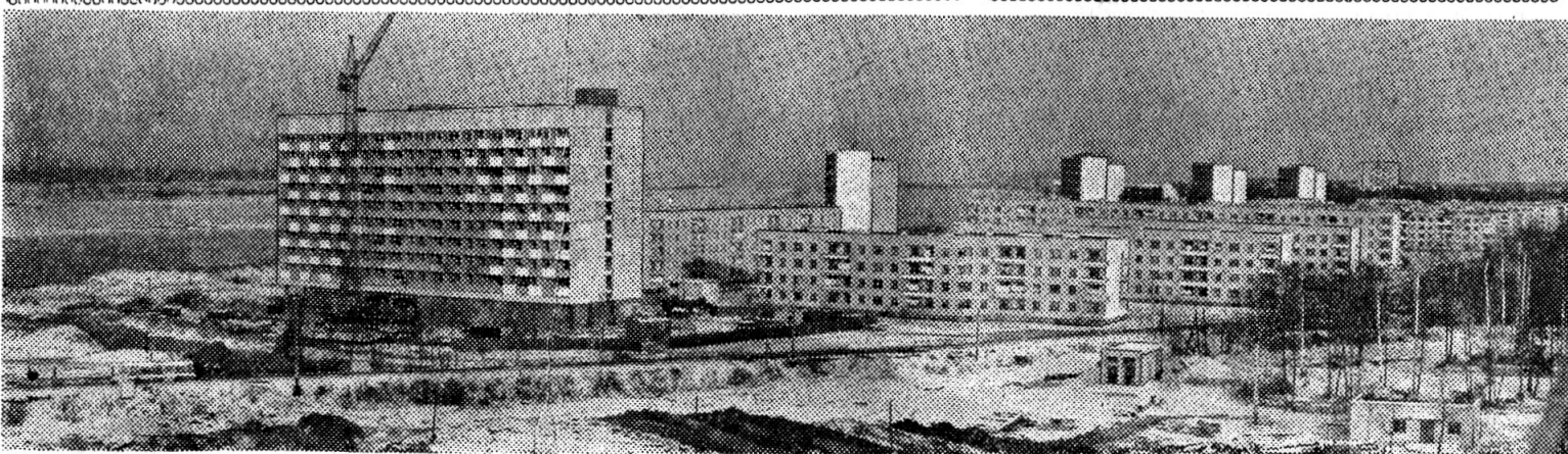
Дубна строится. На месте, где недавно стояли одноэтажные деревянные дома, выросли красивые многоэтажные жилые корпуса. На снимке: общий вид квартала № 21. На переднем плане — строящаяся общежитие.
