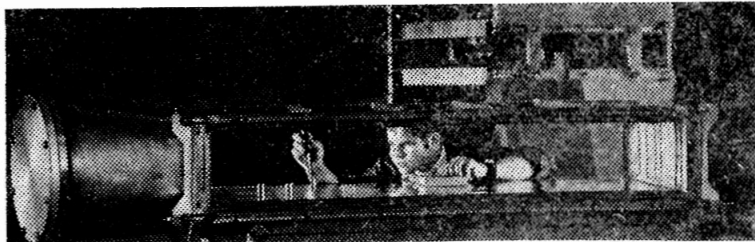
Крепление плакировки в корпусе камеры производит В. П. Виноградов.
