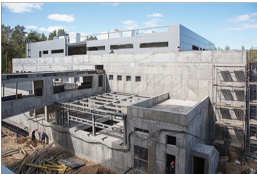
Идут последние строительные работы в здании циклотрона ДЦ-280.
