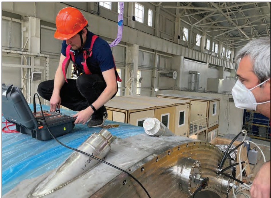
Рис. 3. Проверка целостности сверхпроводящих кабелей обмотки соленоида
