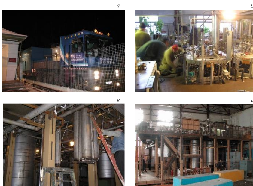
Рис. 2. Модернизация криогенного оборудования. а) Транспортировка МО-800 в ОИЯИ после ремонта; б) демонтаж оборудования на КГУ-1600/4,5; в) демонтаж танка устройства тонкой очистки гелия; г) общий вид комплекса КГУ-1600/4,5 с установленным после ремонта блоком МО-800
