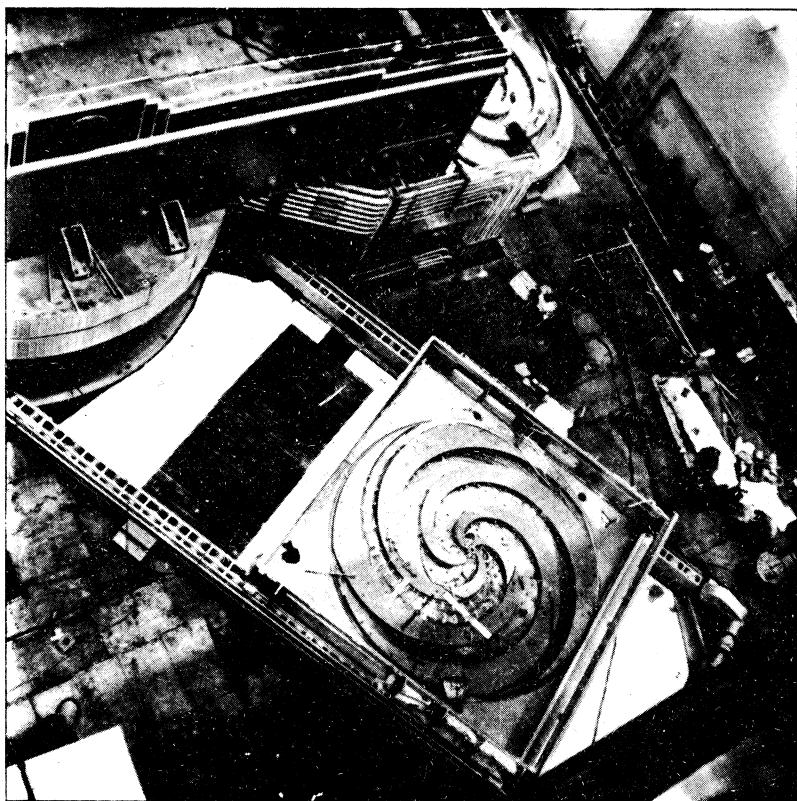
Рис.4. Магнитная система фазотрона ОИЯИ
