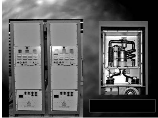
Рис. 29. Два ВЧ-генератора для независимого питания двух дуантов
