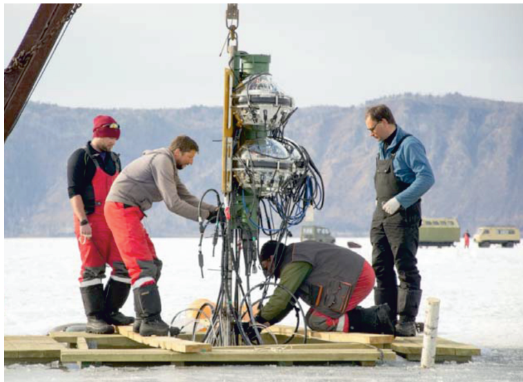
Монтаж гирлянды оптических модулей перед погружением в Байкал
