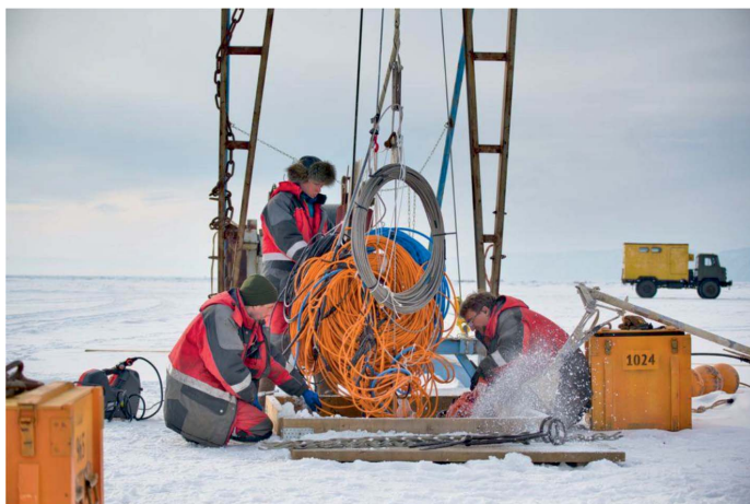
Работы по монтажу гирлянды
