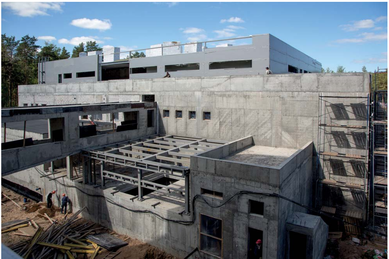
Лаборатория ядерных реакций им. Г.Н. Флерова. Строительство фабрики сверхтяжелых элементов
