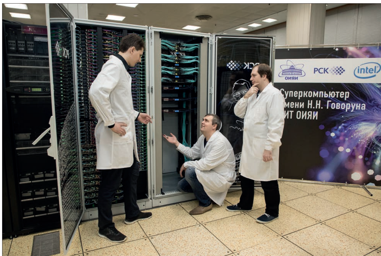
Лаборатория информационных технологий. Монтажные работы на суперкомпьютере «Говорун»
