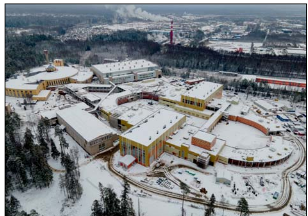
Рис. 3. Общий вид строительной площадки ускорительного комплекса (ноябрь 2020 г.)
