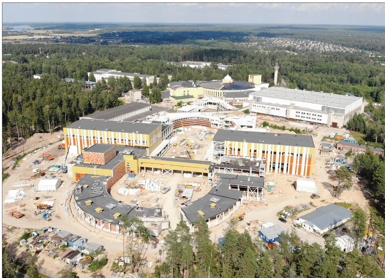
Лаборатория физики высоких энергий им. В. И. Векслера и А. М. Балдина. Стройплощадка комплекса NICA
